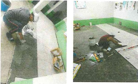
Sustitución de piso de cemento por piso ceramico de 1cm de espesor.
